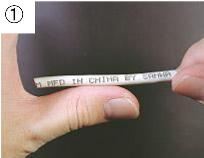
① 先端から親指の長さくらい(約5cm)の部分で被覆を、皮むき工具を使ってはがす。
